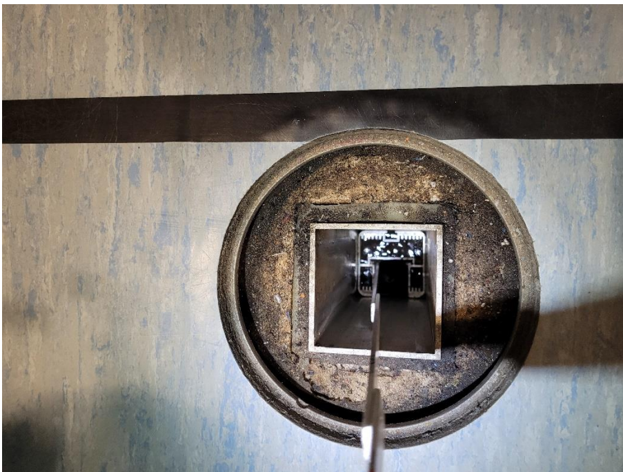
→ Wasser steht in der Bodenhülse
