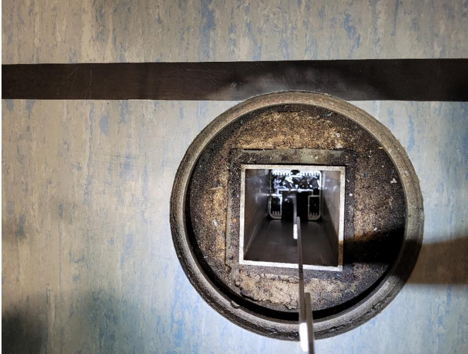
→ Wasser steht in der Bodenhülse
